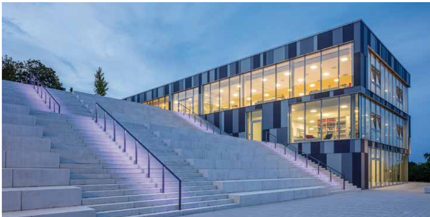
Abb. 1 (Bild oben) Die neue Treppenanlage des Bitburger Willibrord-Gymnasiums in der Dämmerung
